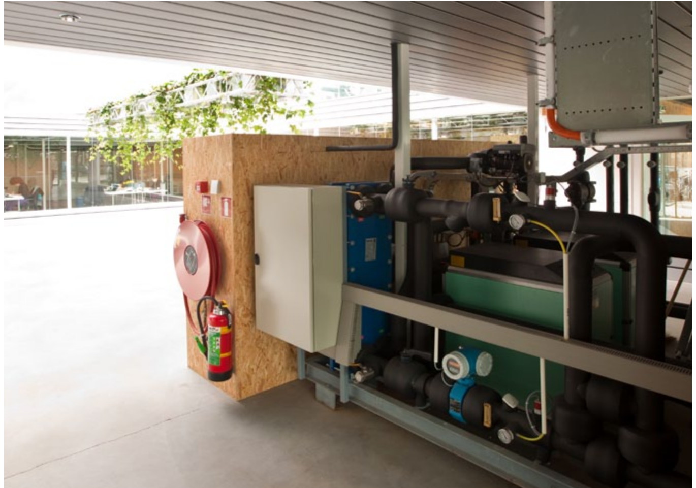
Installatie voor warmteopslag bij een architectenbureau.
