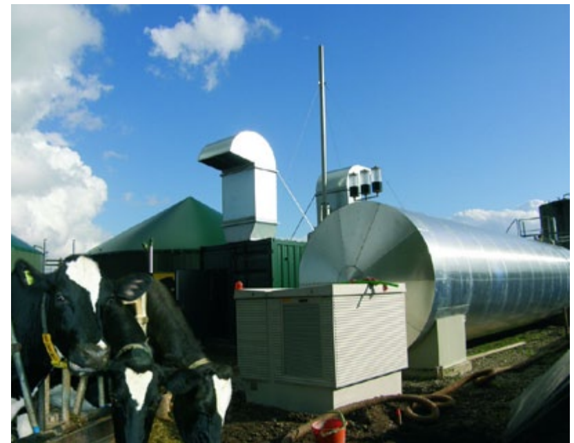
Biogasinstallatie in Zeewolde.
